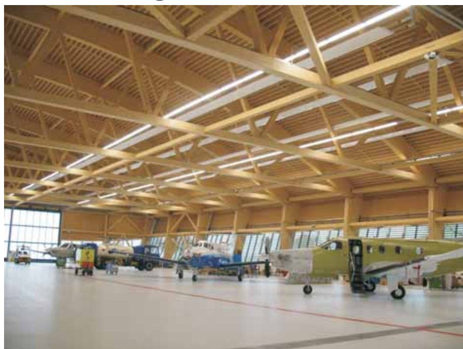
Die «brandneue» Endmontage-Halle der Pilatus-Flugzeugwerke
